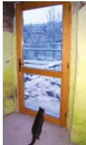
Die neuen Türen sind schon eingebaut ...
